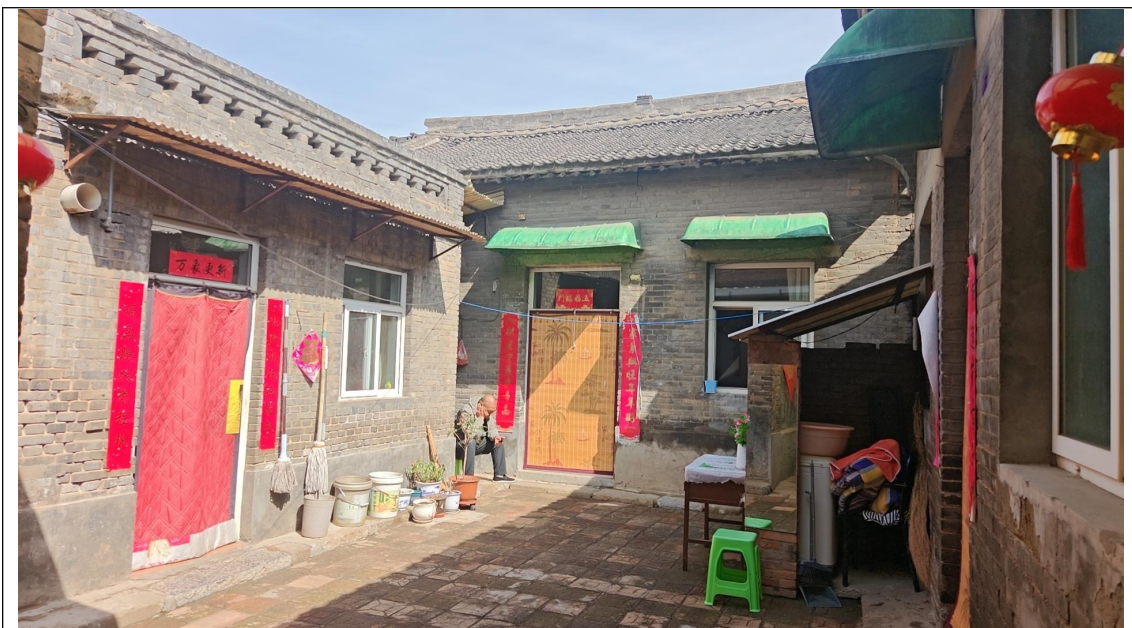
建筑内部照片
