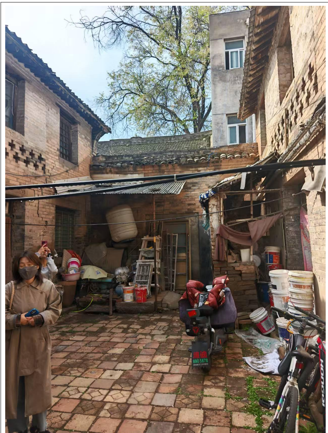
建筑内部照片
