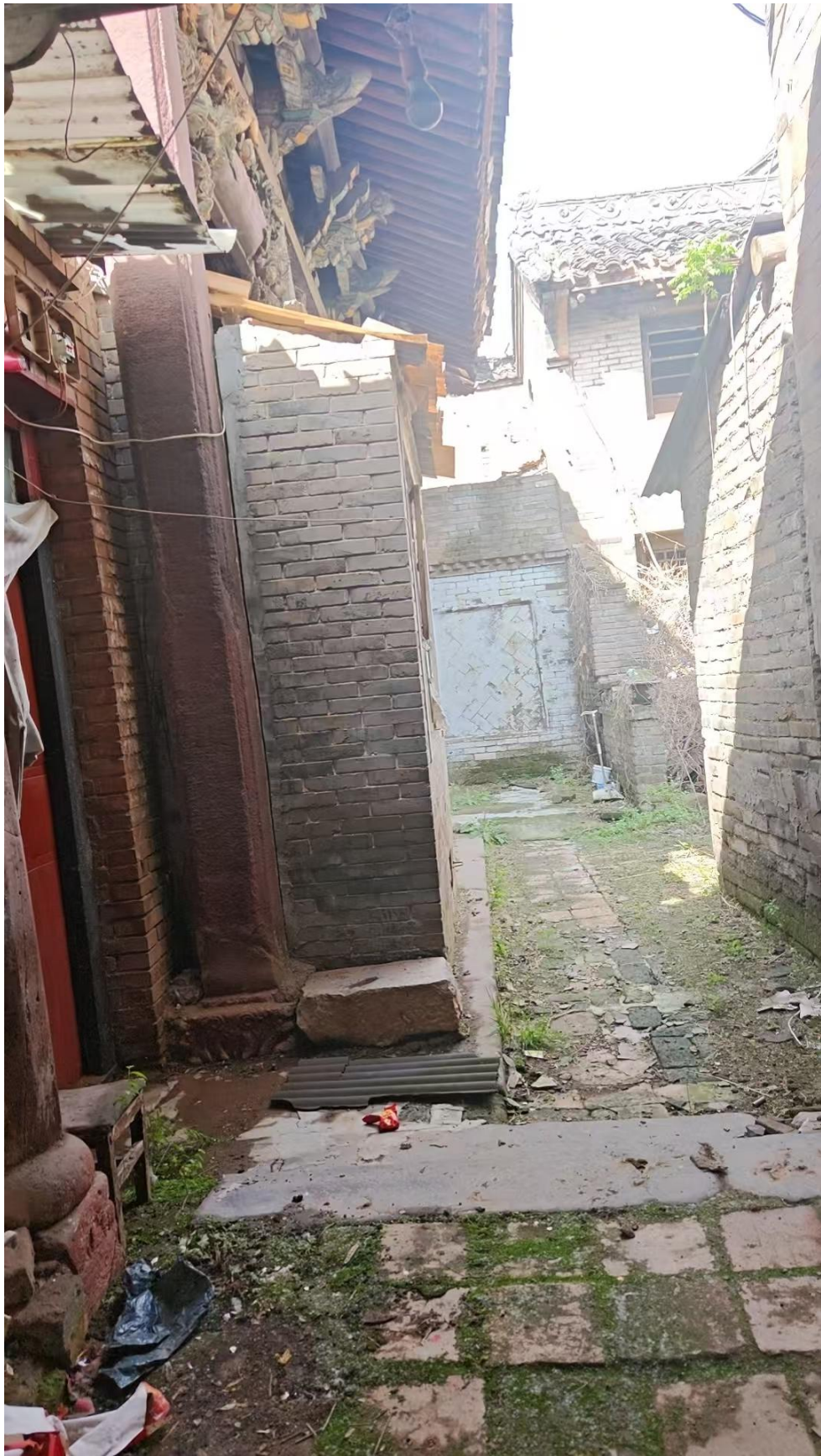
建筑内部照片
