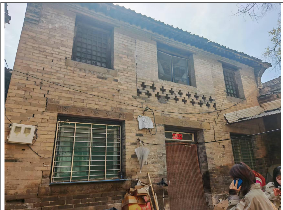
建筑内部照片
