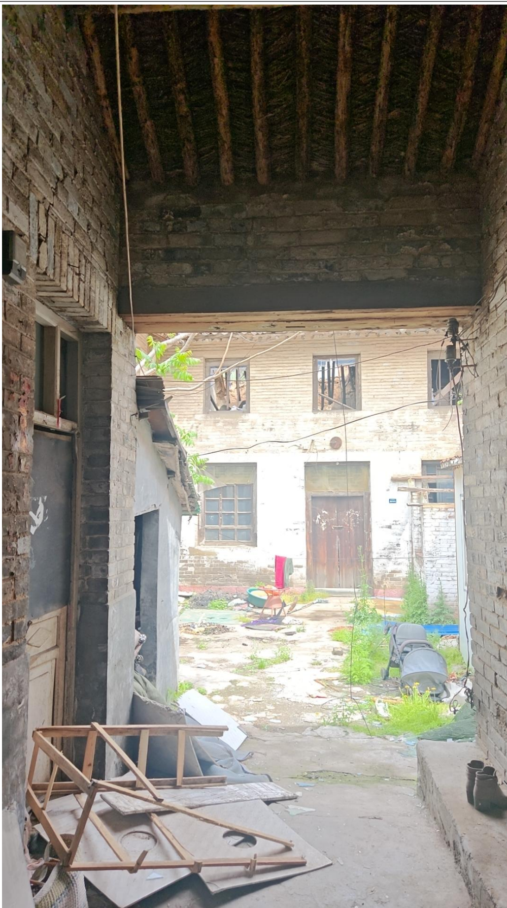
建筑内部照片
