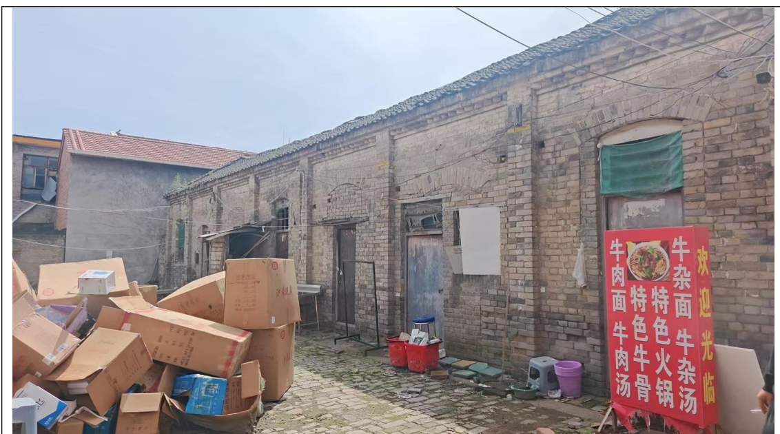
建筑内部照片
