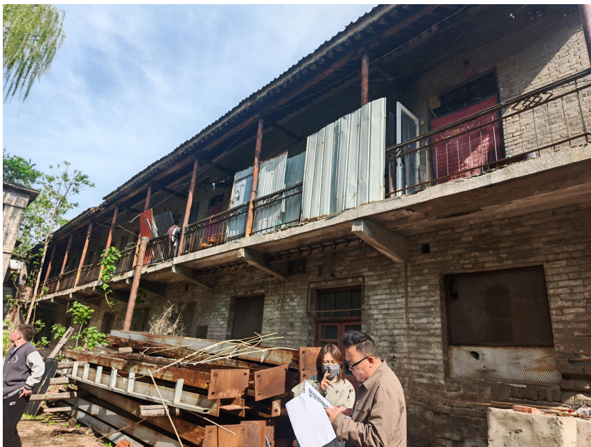
北侧建筑照片
